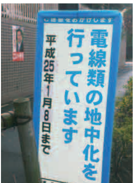
鎌倉街道(中町4丁目付近)で 行われている地中化工事
